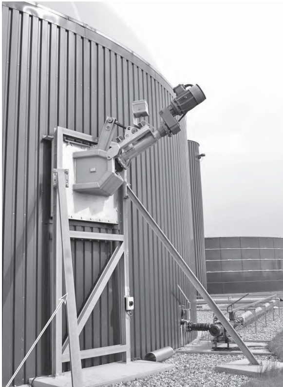
Außenständer-Wand-Konstruktion zum Einsatz in einem Stahlbehälter. Zur technischen Klärung ist vorab ein Fachgespräch notwendig.
