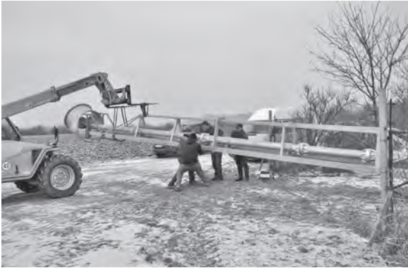
Montage vor Ort
